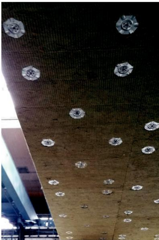
Płyta betonowa z systemem ogniochronnym.
