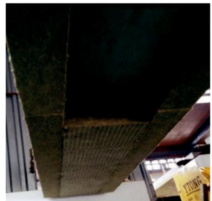
Płyty ogniochronne od spodu belki.
