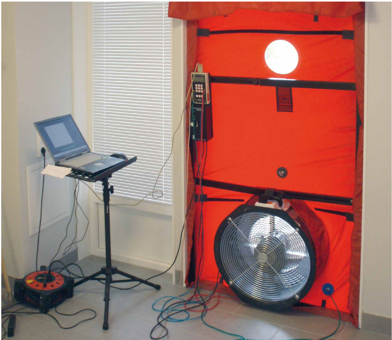
Paveikslas: Sandarumo matavimas parodo nesandarias pastato vietas netgi prieš konstrukcijų sandarinimą.
