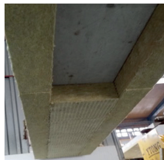
Betonipalkin alapinnan paloeriste
