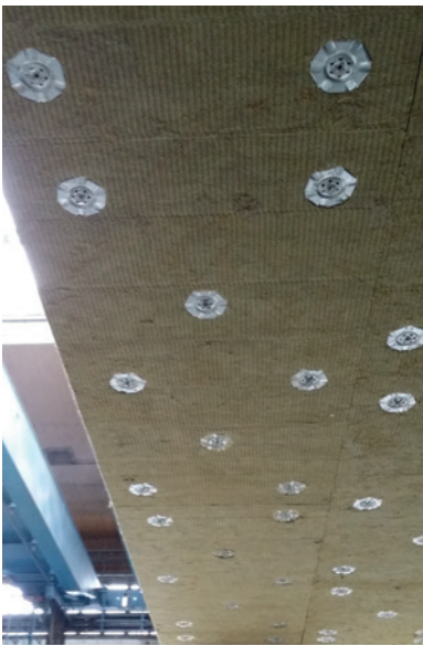
Palosuojattu betonilaatta.
