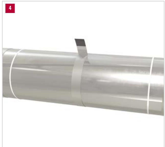
4. **Optimale Haftung:** Bei der Montage des Klebebandes auf Längs- oder Stoßfugen auf faltenfreie und optisch einwandfreie Verklebung achten. Um die Haftung des Klebebandes zu optimieren, Lüfteinschlüsse zu verhindern und um das Klebeband zu glätten, benutzen Sie einen Kunststoffspachtel (Rakel).
