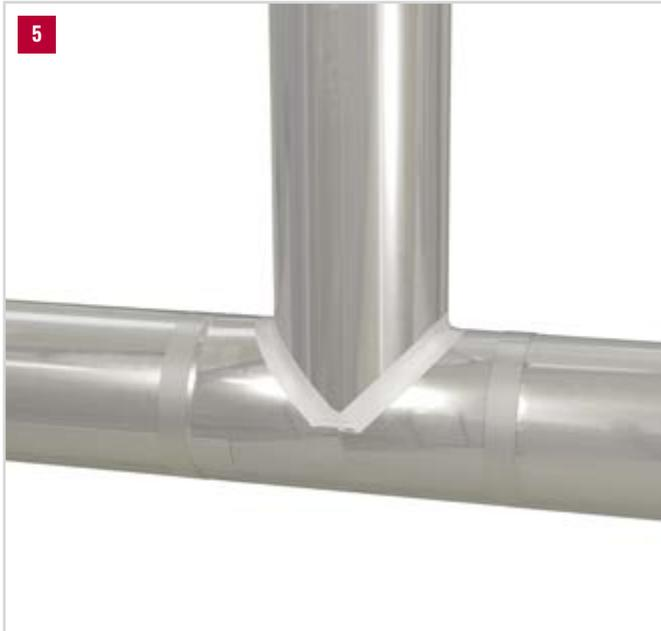
8. Alle Verbindungsteile (T-Stücke, Anbauteile, Halterungen usw.) müssen mit PAROC® Clad Alu Tape abgedichtet werden. Lufteinschlüsse unter dem Klebeband sollten vermieden werden.
