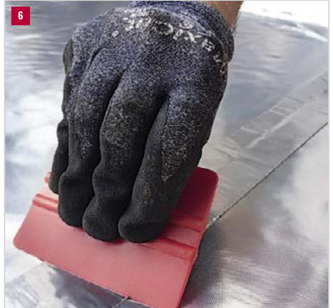
**6.** Verwenden Sie eine Kunststoffspachtel (Rakel), um eine optimale, faltenfreie Verklebung zu gewährleisten.
