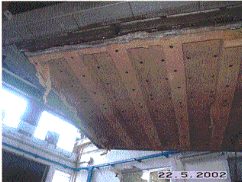
Fig. 3 La faccia esposta del campione dopo la prova Fig. 3 Exposed face of test specimen upon completion of test
