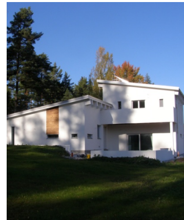
Med passivhus Granbäck visar Paroc att det redan idag är möjligt att bygga så energisnålt som EU kräver.
